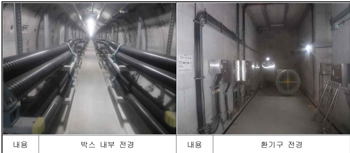
【사진 16.1】 신덕은파주문산CC 전력구 현황
